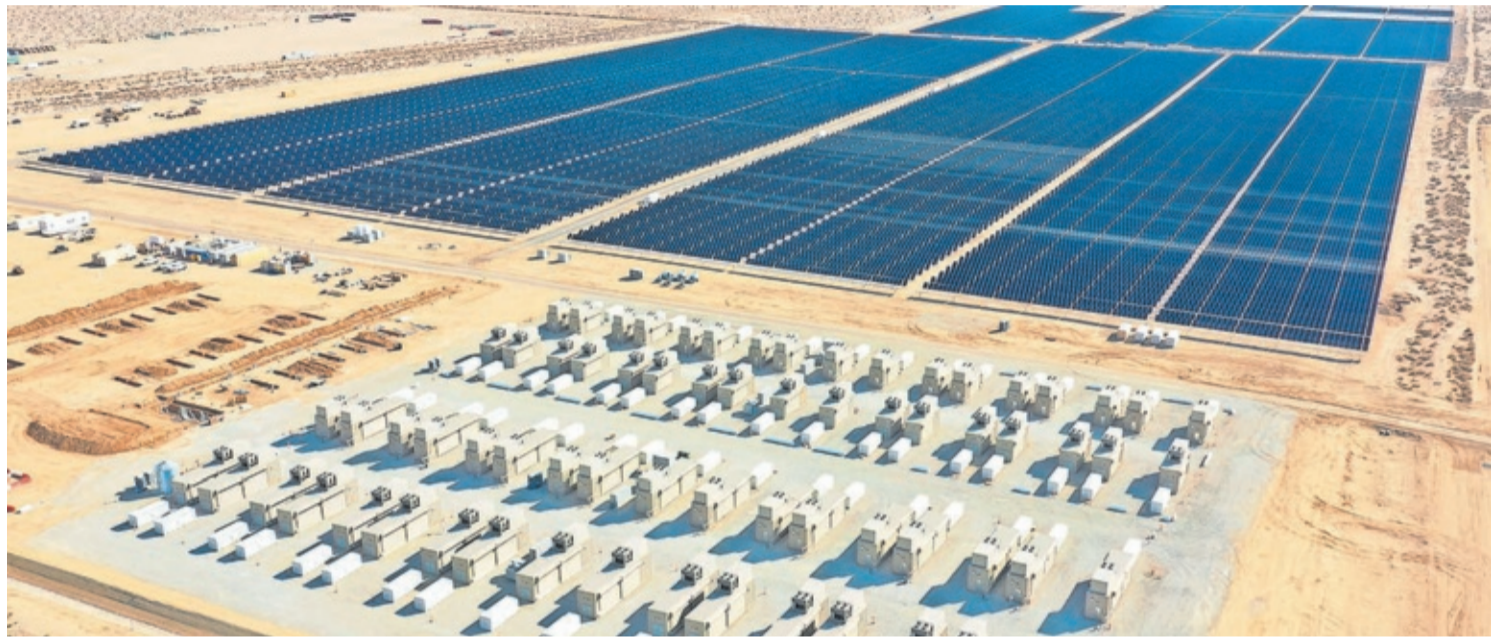
Central de almacenamiento de energía Edwards &amp; Sanborn Solar, en el condado de Kern, California. MORTENSON / TERRA-GEN
